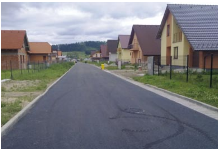
Na Svitskej ulici bola dokončená výstavba cesty.
